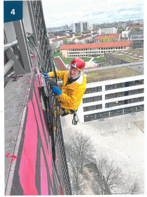
Hochdruckkrake ist aufgrund der Schlauchlänge für die Ver- und Entsorgung mit Wasser außerdem das ideale Werkzeug für die Reinigungsarbeiten an hohen Gebäuden. Daher hatten wir keinerlei Schwierigkeiten, die Graffitis im 17. Stock zu entfernen.“
