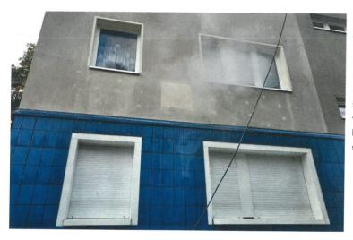
An dem Objekt versagte die klassische Reinigungsmethode: Die Schmutzschicht trotzte 120°C heißem Wasserdampf.
