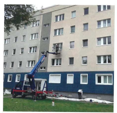
Bei der Fassadenreinigung gingen die Handwerker abschnittsweise vor. Zuvor hatten sie eine mit flüssigkeitsdichter, chemikalienresistenter Folie ausgekleidete Wanne zum Auffangen der Abwässer errichtet. (Fotos: Torsten Höhne)
