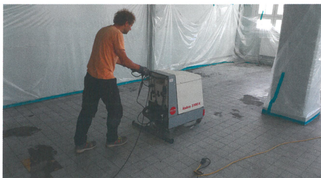
Im letzten Arbeitsschritt wurden die Fliesen mit einem Wischautomaten und einem leicht alkalischen Reinigungsmittel neutralisiert.
