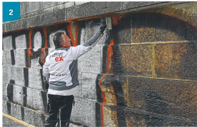
dem spielt das in dem Spray eingesetzte Lösungsmittel eine wesentliche Rolle. Es entscheidet maßgeblich über die Eindringtiefe, die Aushärtungsgeschwindigkeit des Lacks und damit auch über die Alterung eines Graffiti.
